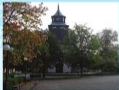
Zvonice na radničním náměstí
